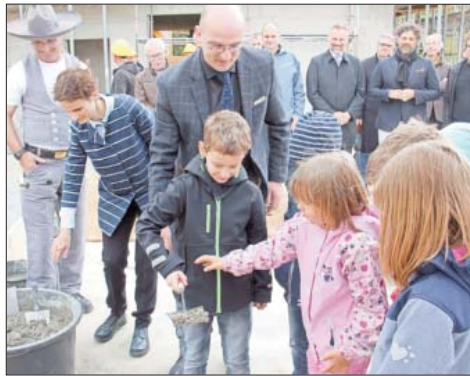
Zukunftsmusik im Mai: Gemeinsam mit Bautzener Kindern legten die Bürgermeister Dr. Robert Böhmer und Juliane Naumann den Grundstein für eine neue Kindertagesstätte am Schützenplatz. Hier stehen künftig 186 Betreuungsplätze in Krippe, Hort und Kindergarten zur Verfügung.
